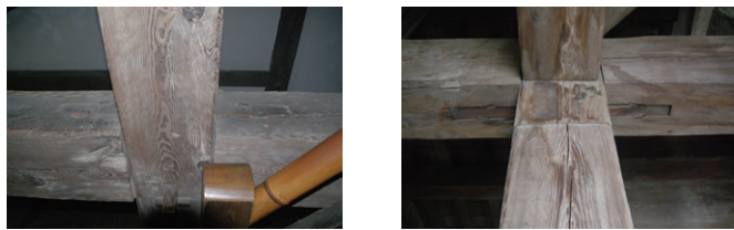
写真1 高松城二ノ丸月見櫓 指物詳細 左写真は上小根、右写真は下小根で雇竿車知継
